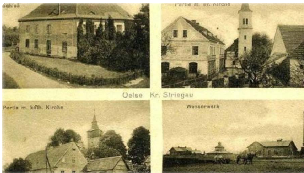
Fot. 2 Olszany - pałac, zabudowania wsi z kościołem ewangelickim, zabudowania z wieżą kościoła katolickiego oraz przedsiębiorstwo wodociągowe. 6 1900-1932
